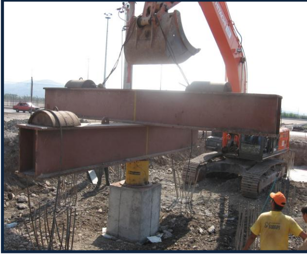
ARKAS HOLDİNG – AUTOPORT KÖPRÜSÜ TEST KİRİŞLERİNİN MONTAJI Ve YÜKLEME DENEYİ
