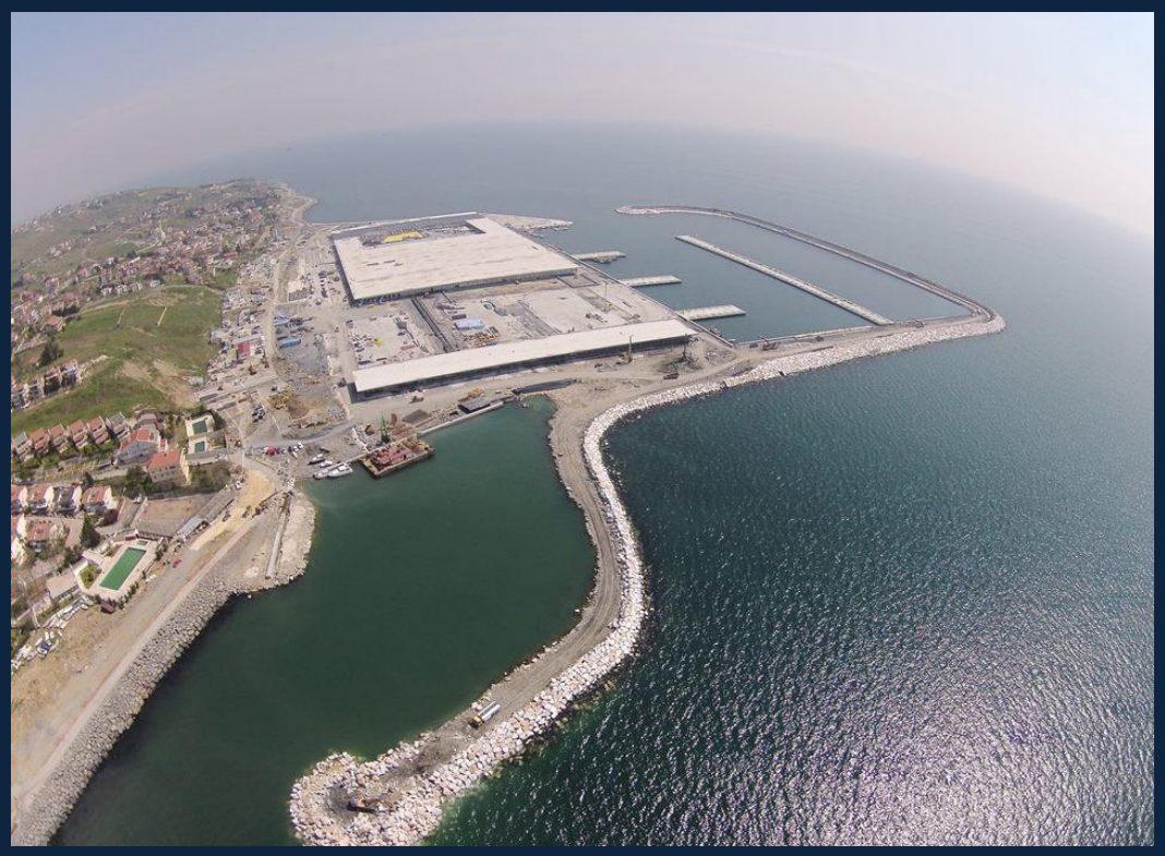
BEYLİKDÜZÜ / GÜRPINAR BALIKÇI BARINAKLARI İŞİ FİNAL FOTO - III
