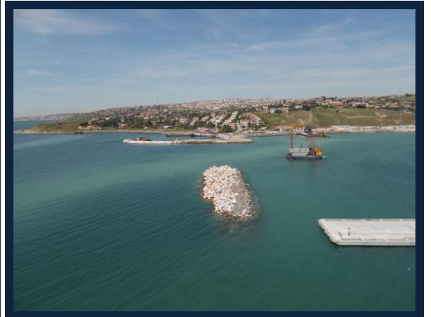
BEYLİKDÜZÜ / GÜRPINAR BALIKÇI BARINAKLARI İŞİ 90 Tonluk T-WALL BLOK MONTAJI
