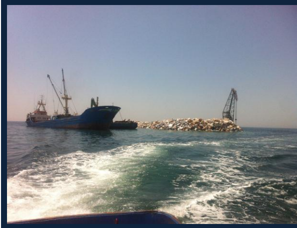
BEYLİKDÜZÜ / GÜRPINAR BALIKÇI BARINAKLARI İŞİ 90 Tonluk T-WALL BLOK MONTAJI
