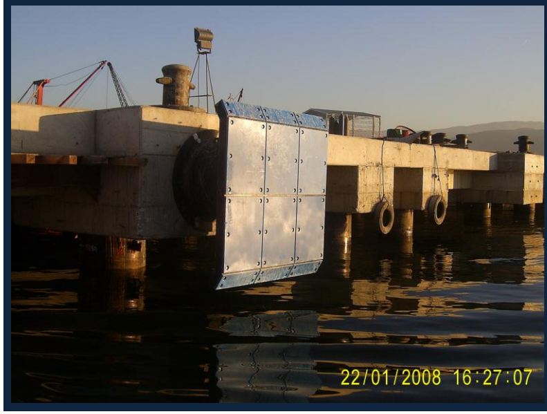
ARKAS HOLDİNG – AUTOPORT LİMANI - 35 Tonluk USTURMAÇA UGULAMASI
