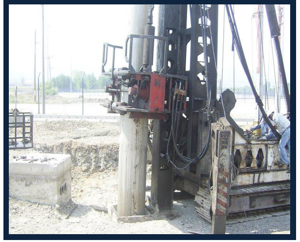
ARKAS HOLDİNG – AUTOPORT KÖPRÜ KAZIKLARI - VİBREX KAZIK UYGULAMASI
