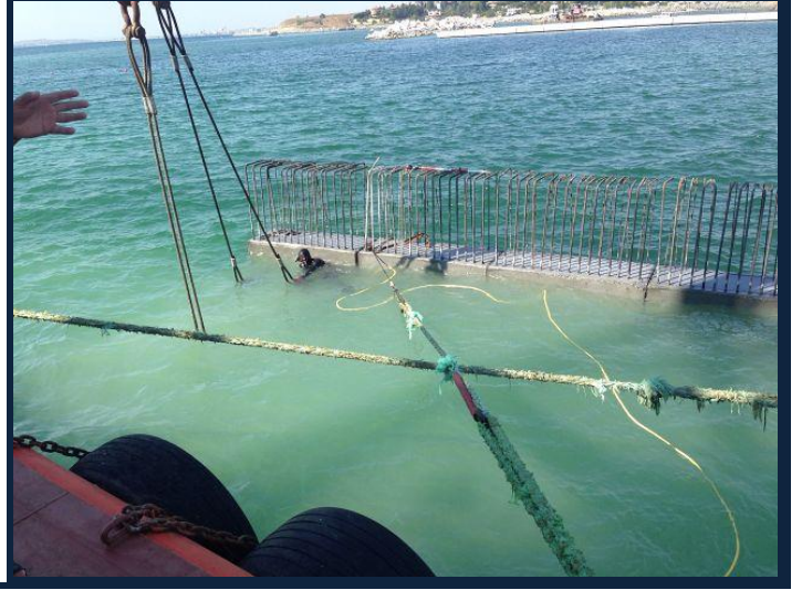
BEYLİKDÜZÜ / GÜRPINAR BALIKÇI BARINAKLARI İŞİ 90 Tonluk T-WALL BLOK MONTAJI
