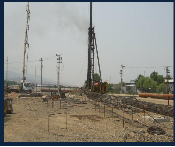
ARKAS HOLDİNG – AUTOPORT KÖPRÜ KAZIKLARI - VİBREX KAZIK UYGULAMASI
