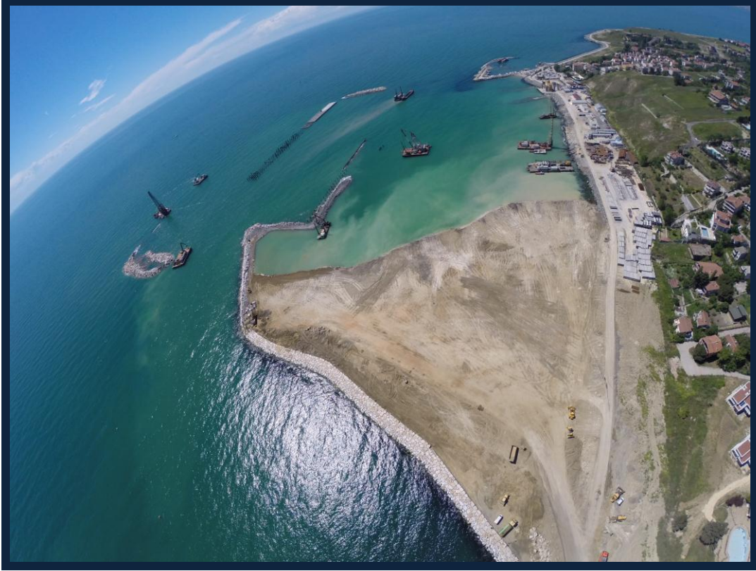
BEYLİKDÜZÜ / GÜRPINAR BALIKÇI BARINAKLARI İŞİ YAPIM AŞAMASI
