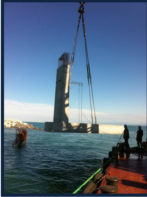
BEYLİKDÜZÜ / GÜRPINAR BALIKÇI BARINAKLARI İŞİ 90 Tonluk T-WALL BLOK MONTAJI
