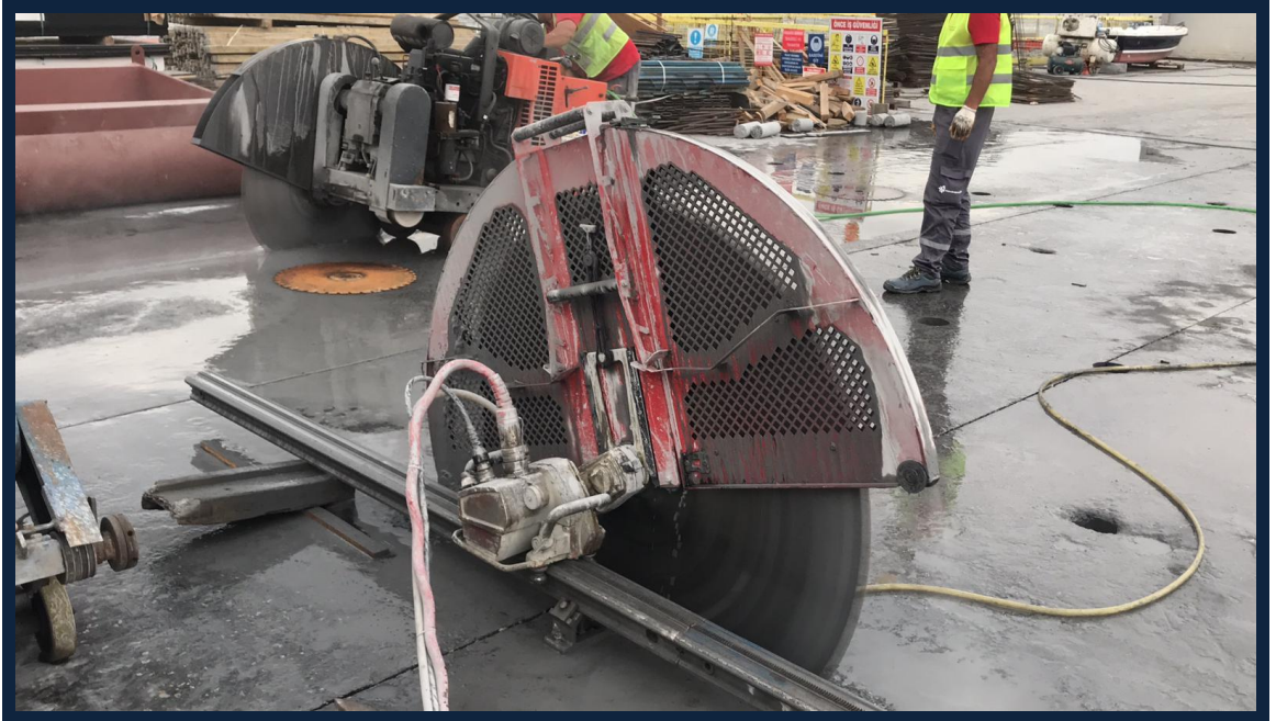
MARDAŞ – İSKELE YENİLEME / GÜÇLENDİRME PROJESİ - 2021
