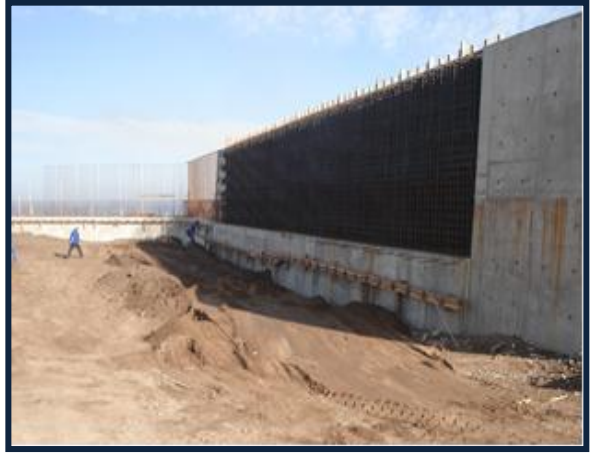
MOROCCO / SAMIR Rafinerisi / h=8 m , L= 600 m OKYANUS SINIR DUVARI
