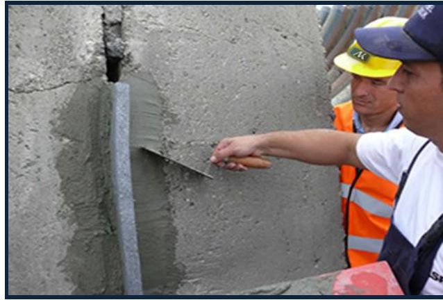
AKINCI 4.ANA JET ÜSSÜ F-16 SİĞINAKLARI YÜZEY KAPLAMA ve SU İZOLASYON UYGULAMASI
