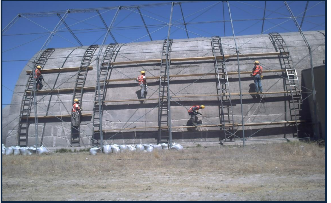
AKINCI 4.ANA JET ÜSSÜ F-16 SIĞINAKLARI YÜZEY KAPLAMA ve SU İZOLASYON UYGULAMASI
