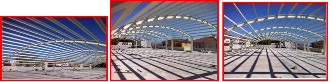
KOCAELİ SANAYİ ODASI İLK OKULU DIŞBÜKEY ÇATI KONSTRÜKSİYON İMALATI
