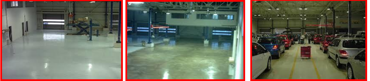
GEFCO PDI CENTER KÖSEKÖY EPOKSİ ZEMİN YÜZEY KAPLAMA UYGULAMASI
