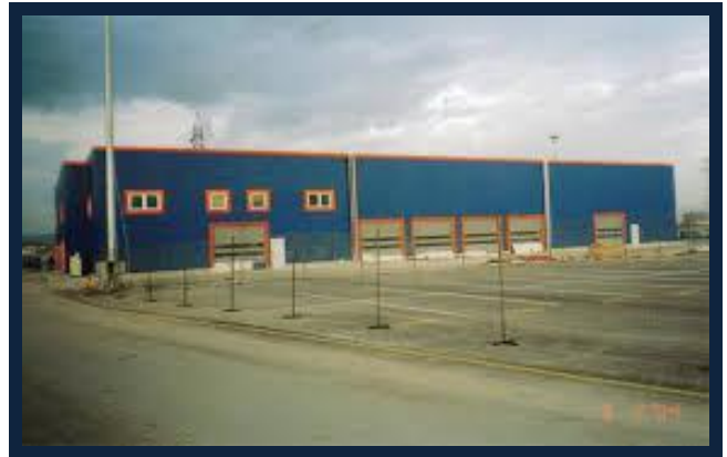
GEFCO PDI CENTER KÖSEKÖY ÇELİK KONSTRÜKSİYON / CEPHE ve ÇATI PANELİ UYGULAMASI 150.000 m 2 ANTREPO SAHASI ( ANAHTAR TESLİM )
