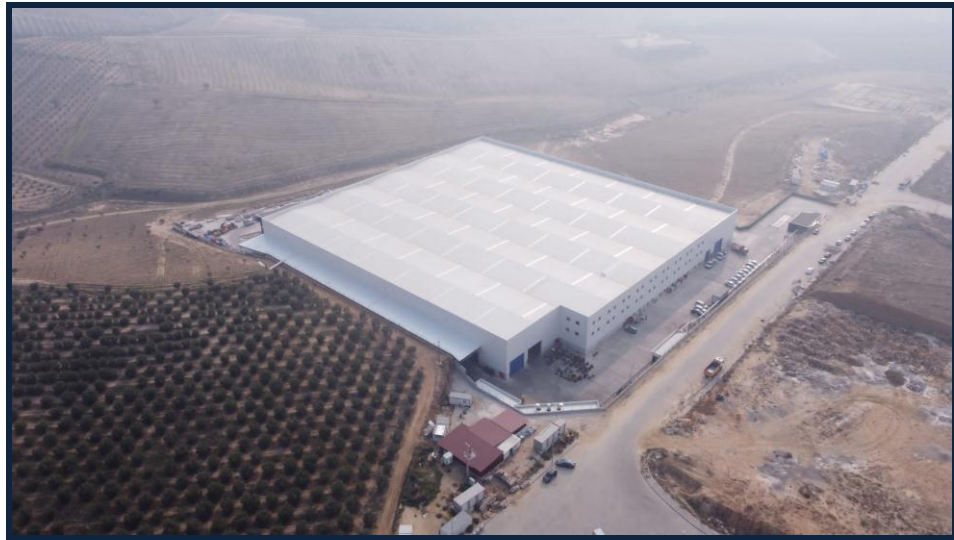
VERGO ENERJİ SALİHLİ OSB FABRİKA İNŞAATI
