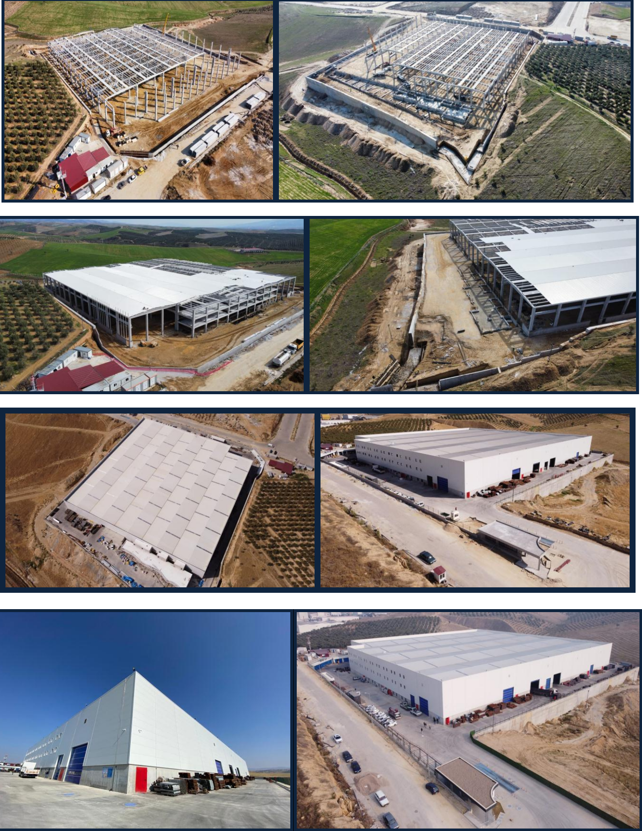
VERGO ENERJİ SALİHLİ OSB FABRİKA İNŞAATI
